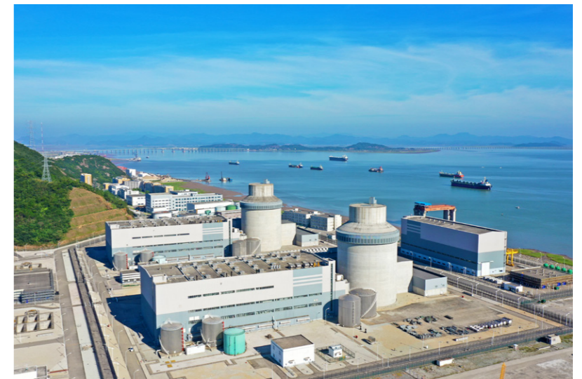
三门核电一期工程
