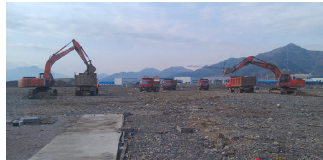
三门核电3、4号机组的循环水压力钢管利用之前负挖产生的塘渣进行回填
