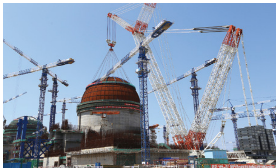
“华龙一号”全球首堆示范工程福清核电5号机组穹顶吊装成功
