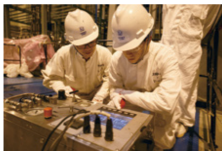
田湾核电站1号机组大修
